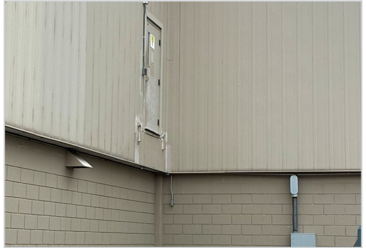
B1 stair demo - exterior door
