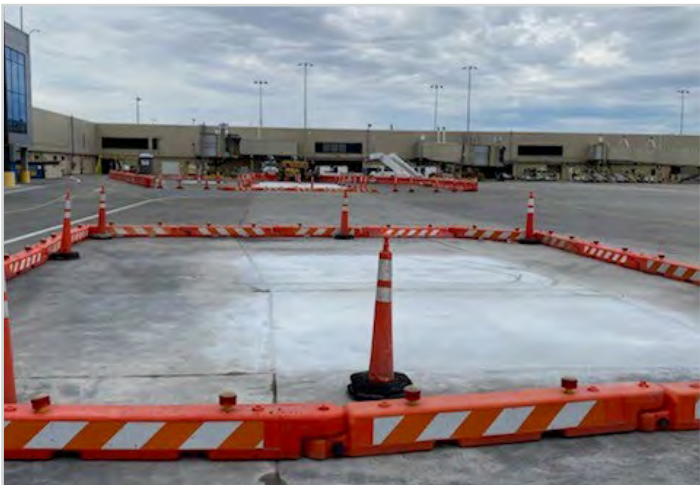
Trench Area 7E - Paving
